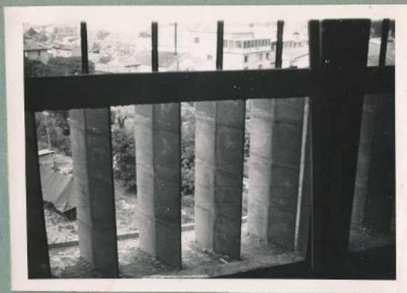
N°15/47 Immeuble Le Corbusier - "Pierres-bleues" des colonnades
