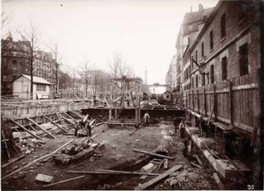
Station " RUE SAINT-SABIN " MISE EN PLACE DU TABLES MÉTALLIQUE
