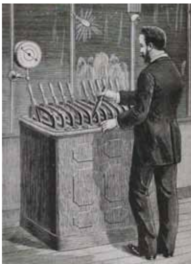
Intérieur du poste d'observation de la Fontaine lumineuse
