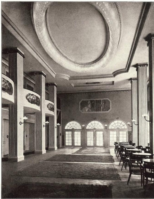
Abb. 46. U.-T. AM ALEXANDERPLATZ ERFRISCHUNGSRaum ARCHITECTEN SCHLEYER UND BÖHLING
