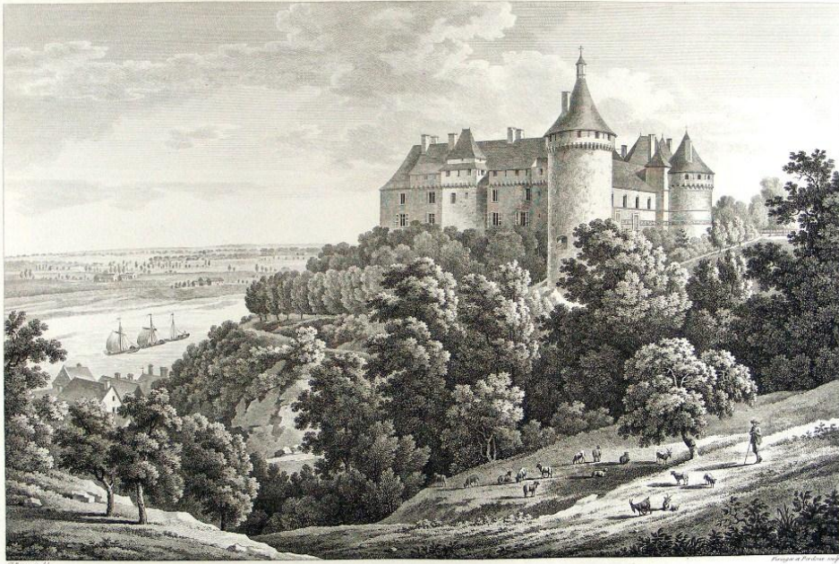
Vue latérale du Château de Chaumont, sur la Loire.
