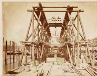
DONAUBRÜCKE WIEN SCHLÜSSENANSICHT
