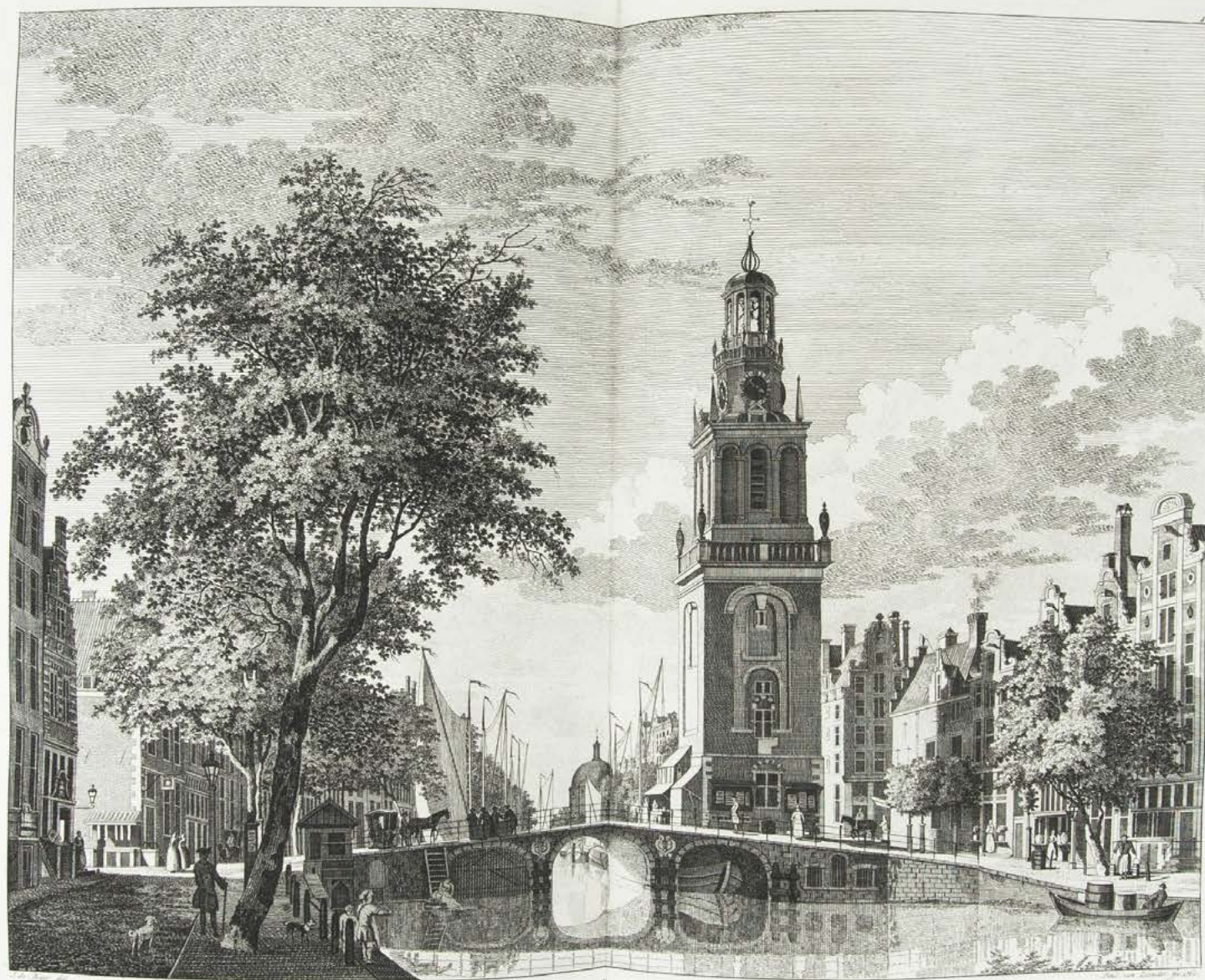
GEZICHT van de JAN-ROODEN-POORTS-TOOREN, te Amsterdam.
