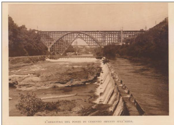
L'ARMATURA DEL PONTE IN CEMENTO ARMATO SULL'ADDA.
